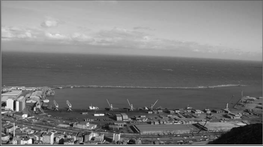
Fotoğraf 1.2. Trabzon Limanı'nın güneyden (Boztepe) görünümü.
