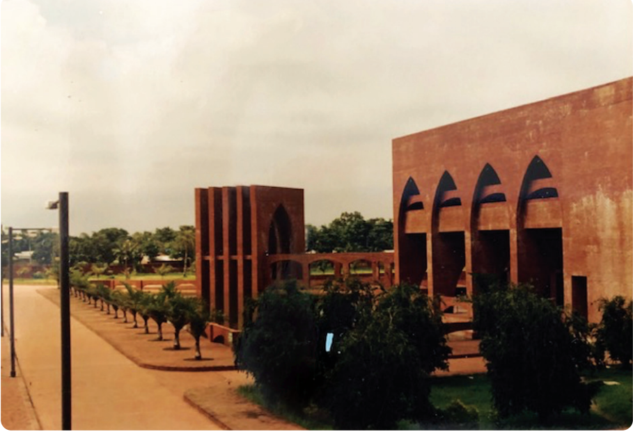
Türk mimar tarafından yapılan Bangladeş İslam Teknoloji Üniversitesi binası
